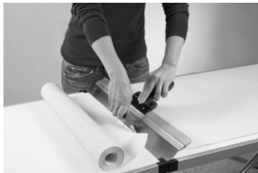
Zuschneiden der Tapetenbahn
