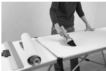
Einkleistern der Tapetenbahn
