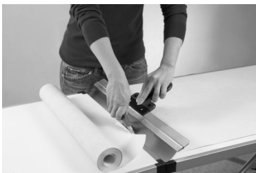
Zuschneiden der Tapetenbahn
