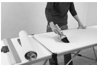
Einkleistern der Tapetenbahn
